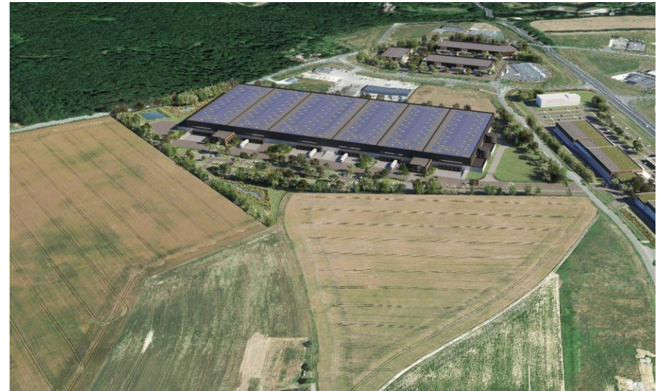
Figure 179 - Vue aérienne du projet logistique sans et avec projet
